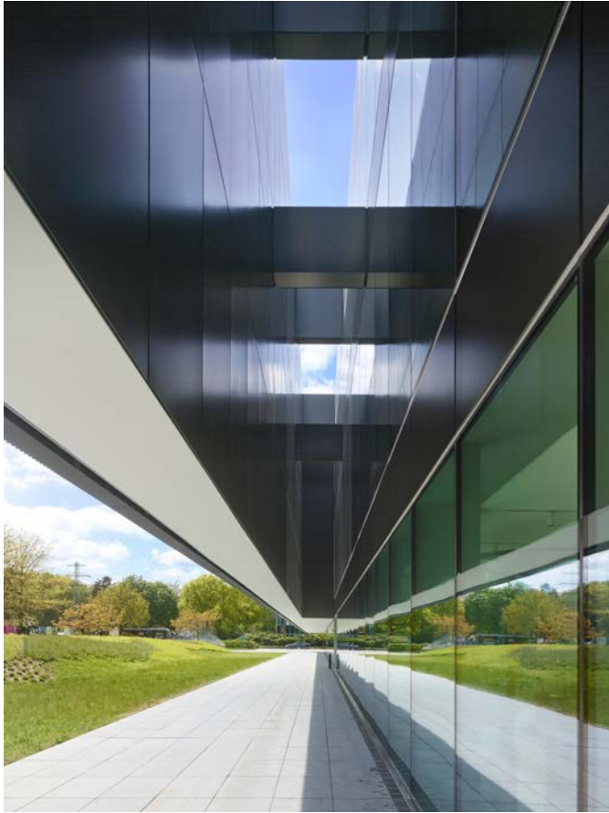
Bild 2 Die Auskragung des Fassadentragwerks an der Vorderseite des Gebäudes (Copyright: Roland Halbe, Stuttgart) The cantilever of the façade support structure at the front of the building
