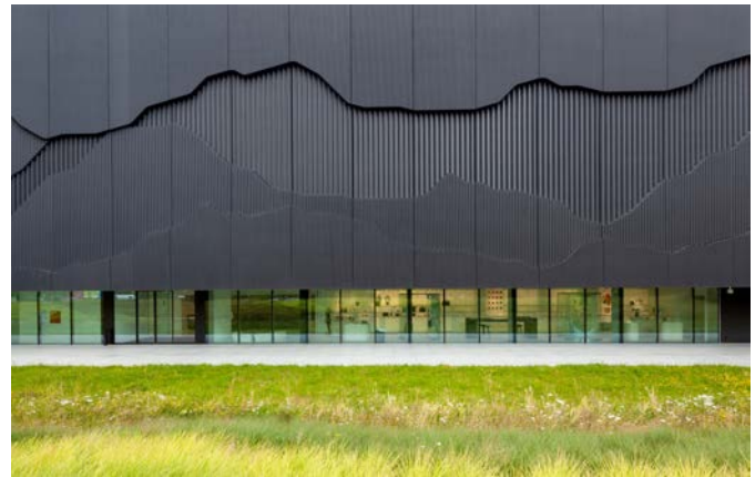
Bild 4 Detailsicht der Fassade: die unterschiedliche Oberflächenbeschaffenheit der einzelnen Paneele wird hier besonders deutlich (Copyright: Margot Gottschling, Overrath) Detailed view of the façade: the different surface finishes of the individual panels are particularly clear here
