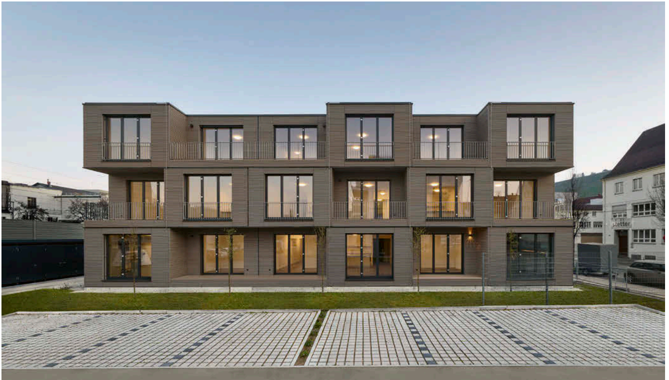
Bild 4 Die von Werner Sobek für die AH Aktiv-Haus GmbH entwickelten Holzmodule ermöglichen eine industrielle Vorfertigung mit sehr hohen Qualitätsanforderungen – hier bei einem Wohnprojekt in Esslingen eingesetzt
