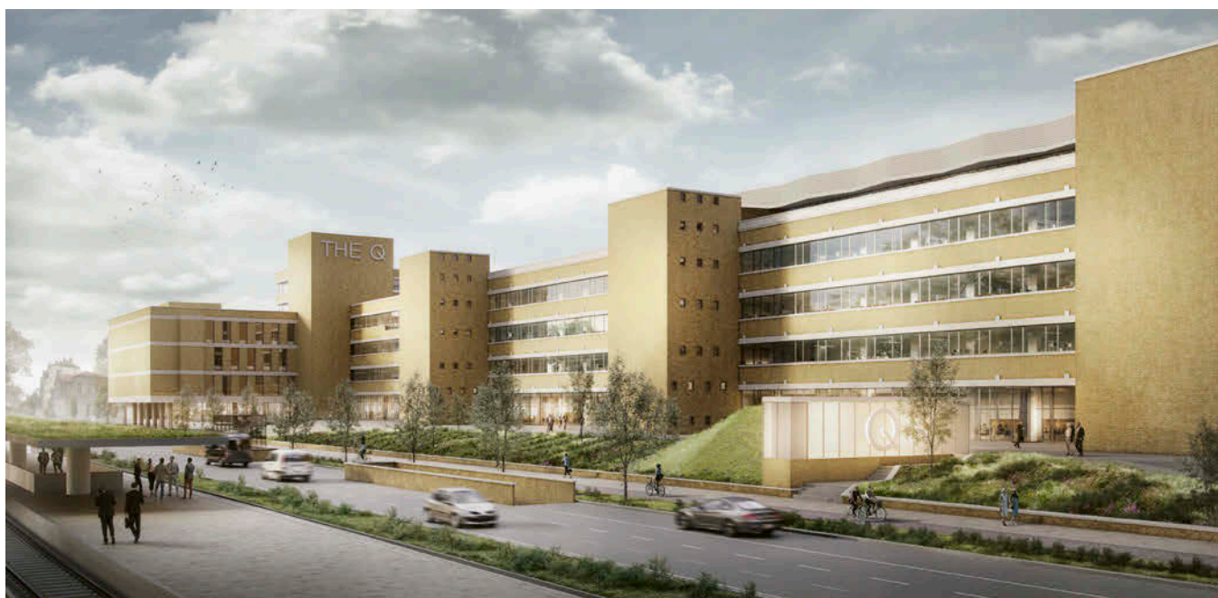
Bild 1 The Q – die Revitalisierung des ehemaligen Quelle-Areals in Nürnberg vermeidet die Emission von mehr als 33.000 t an CO 2 -Äquivalenten, die ansonsten bei Abbruch und Errichtung eines Neubaus angefallen wären
