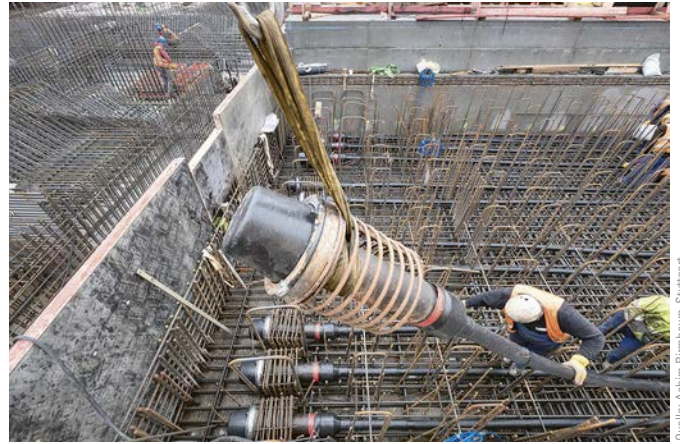
Bild 7 Verlegung der Längsspannglieder, im Vordergrund der Festanker Laying the longitudinal tendons, in the foreground the fixed anchor
