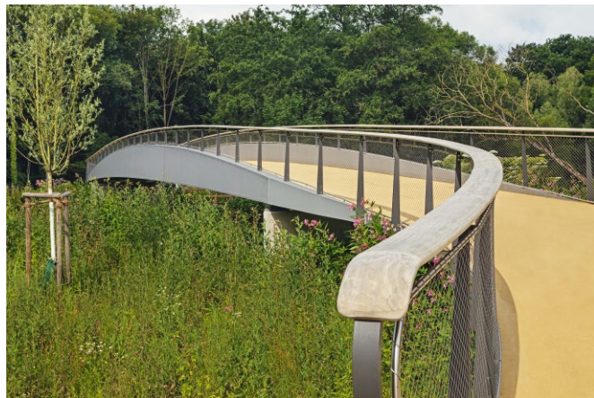
Bild 6 Brückenauftakt mit Holzhandlauf und Edelstahlseilnetz Bridge opening with wooden handrail and stainless steel cable net
