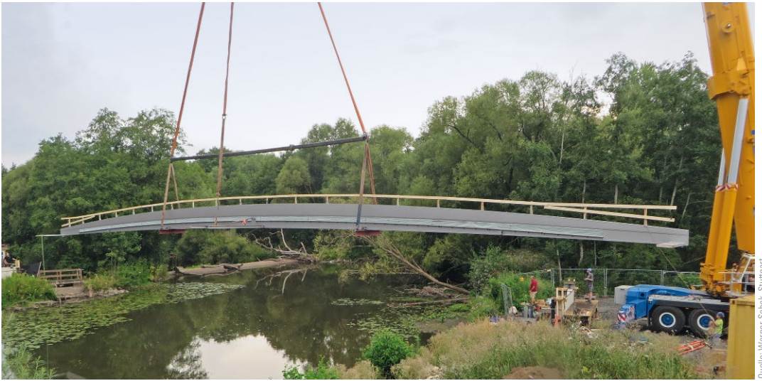
Bild 8 Einheben der Hauptträger Lifting of the main beam
