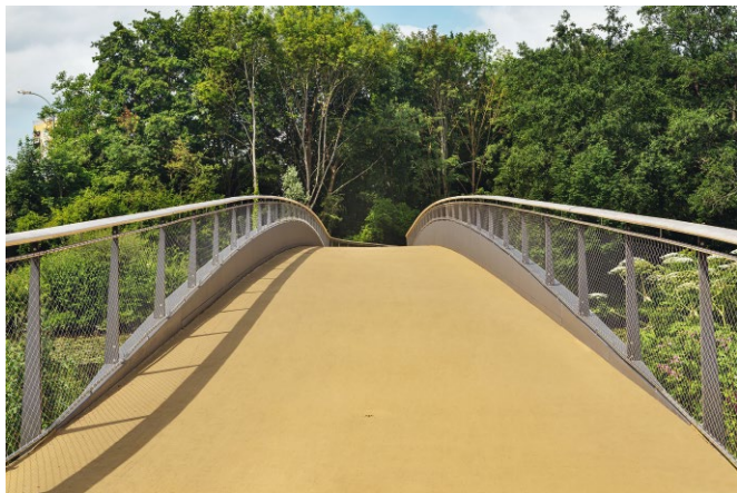
Bild 4 Fugenloser Übergang von Vorlandbrücke zu Hauptbrücke Jointless transition from foreshore bridge to main bridge
