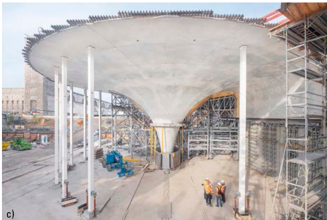
Bild 2. Der neue Tiefbahnhof in Stuttgart. a) Blick in die neue Bahnsteighalle – die sogenannten Kelchstützen sind zentrales Element des Entwurfs (Copyright: Ingenhoven Architekten, Düsseldorf); b) Kelchstütze – Darstellung der Bewehrungsspuren im Rhinoceros-Modell (Copyright: Werner Sobek, Stuttgart); c) Bis zum Schließen der Deckenfelder werden die Kelchstützen von temporären Stützen vor ungewollten Verformungen geschützt (Copyright: Achim Birnbaum, Stuttgart)
